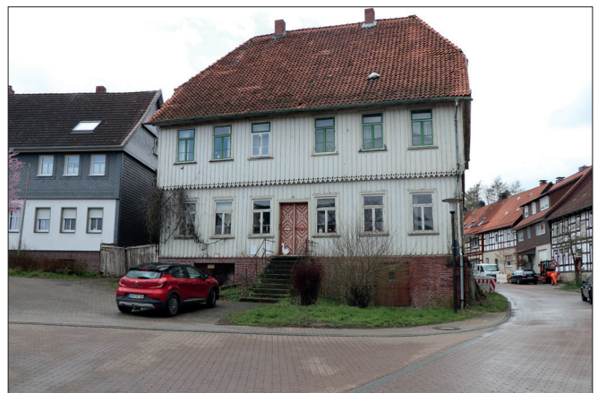
Abb. 22: Sanierungsbedürftiges Gebäude, Junker Gasse
