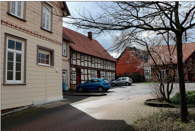
Abb. 23:Innenhof Gemeindezentrum mit Alter Schule
